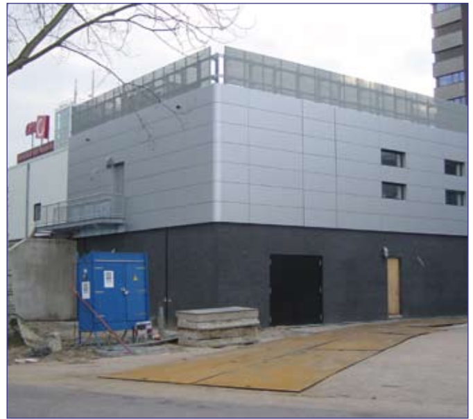
Figuur 2. Recent opgeleverde nieuwbouw waarin de PET/CT geplaatst is. Het betreft een uitbouw van het AMC. Binnen hetzelfde gebouw staat ook een 3-T MRI.
