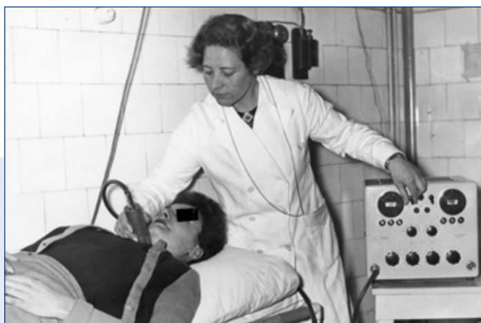
Figuur 7. Schildklier Puntmetingen met een gecollimeerde geiger-müllertelbuis. Voor berekening van de dosis NaI-131 voor schildkliertherapie werd uitgegaan van onder meer de grootte van de schildklier, die eerst met deze puntmetingen werd bepaald.
