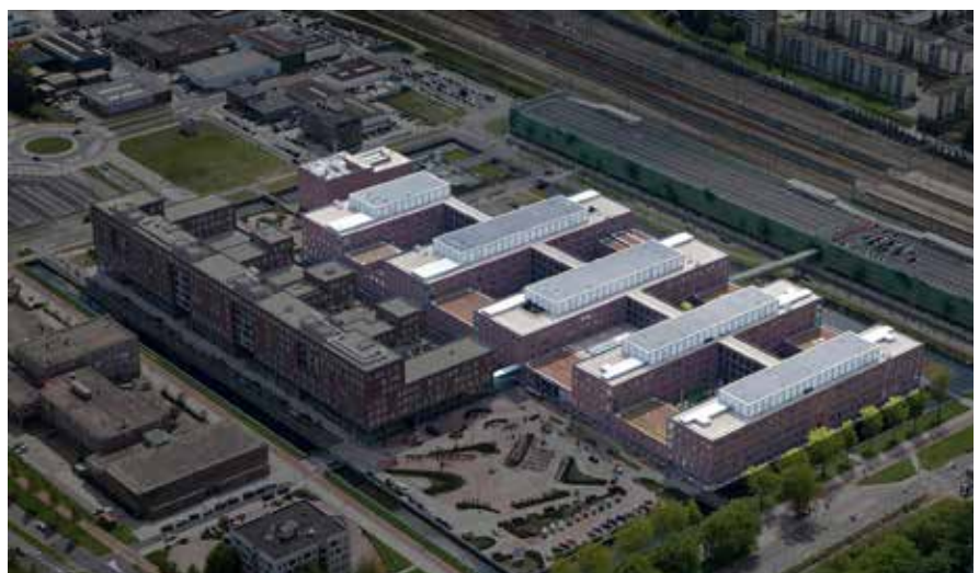
Het Maasstad Ziekenhuis luchtfoto, uitgelicht.
