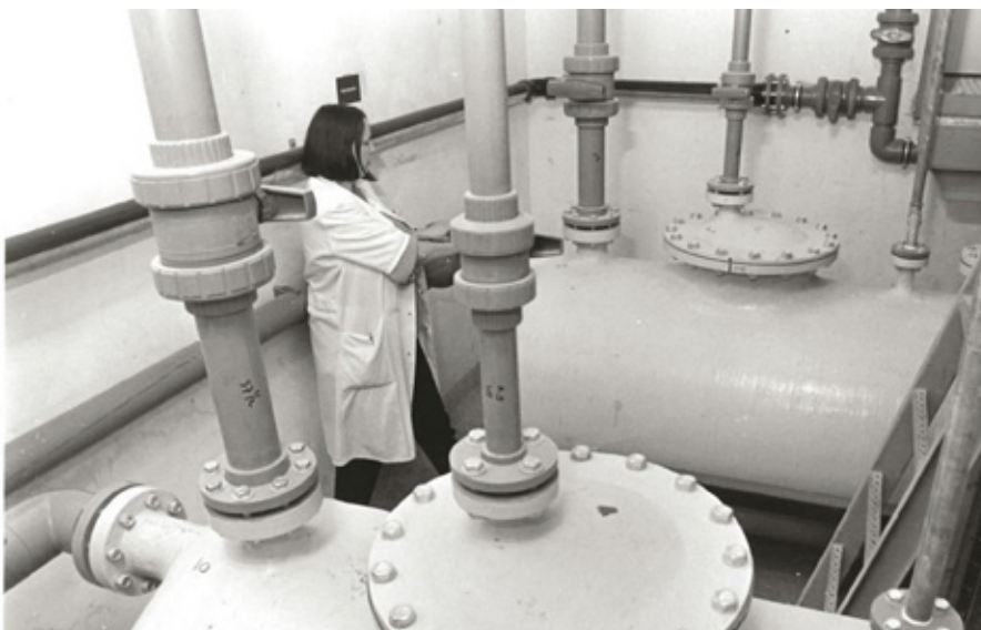
Foto 4. Opslagtanks afval I-131.
